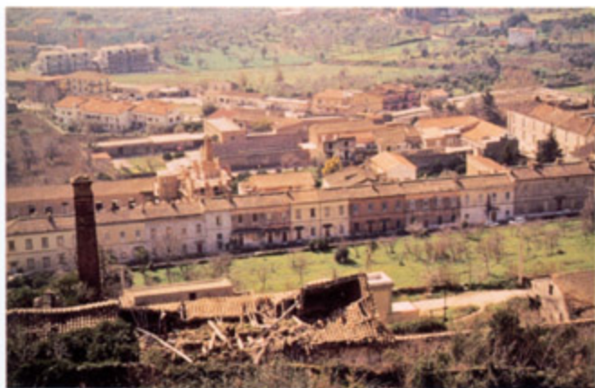
Bloques de viviendas de los obreros de la fábrica de tejidos.
